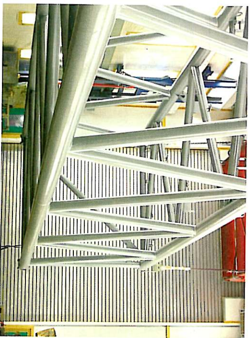
Die Kranteile werden manuell zweimal nass-in-nass (ZK-EP-Hydrogrundierung und ZK-PUR-Füller) beschichtet.
